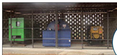
Citernes diesel - Groupes électrogènes
